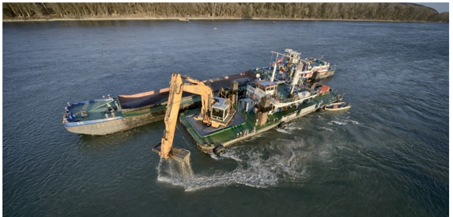
Baggerung auf der österreichischen Donau mit Tieflöffel-Nassbagger und Baggerstelzenponton in der freien Fließstrecke zwischen Wien und Bratislava
