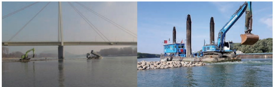
Wasserbauliche Optimierung auf der österreichischen Donau: Verlängerung von bestehenden Buhnen bei Bad Deutsch-Altenburg und Treuschütt in der freien Fließstrecke zwischen Wien und Bratislava
