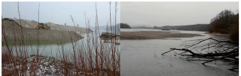
Wasserbauliche Optimierung auf der österreichischen Donau: Inselschüttung in der Furt Rote Werd in der freien Fließstrecke zwischen Wien und Bratislava
